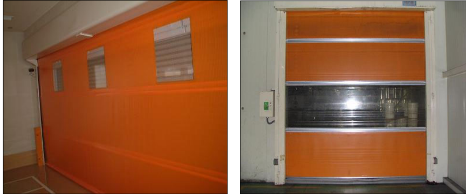
그림 39. 감시창이 설치된 비닐 시트서터
