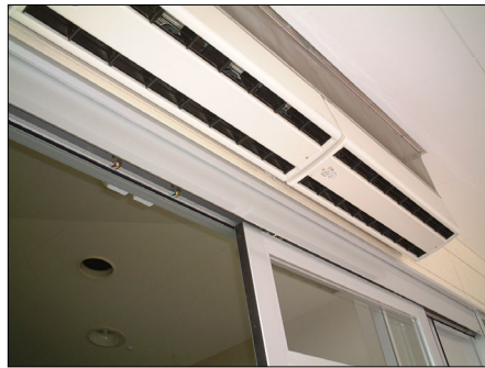
그림 46. 에어커튼이 설치된 출입구
