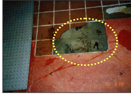
그림 61. 타일 마감된 바닥. 시공이 치밀하지 못하면 유지보수가 필요하다(우측 그림)
