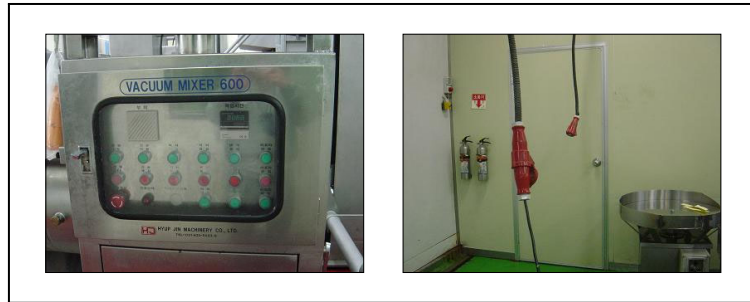
그림 147. 전기 조작반 방수설치 예
